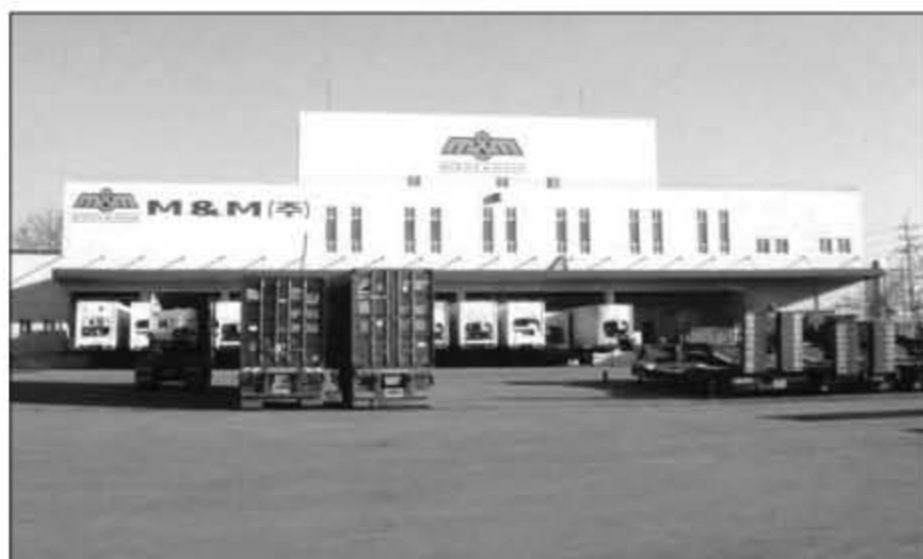
LME 지정창고 등록을 마친 M&M 창고 전경.
